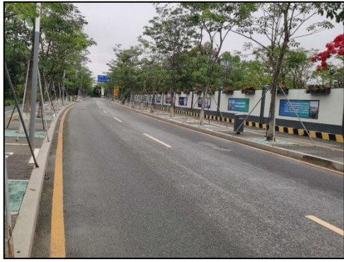
图错误!文档中没有指定样式的文字。-1 泥墙排路北段改扩建段现状道路
