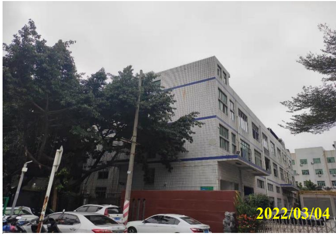
项目北面工业厂房
