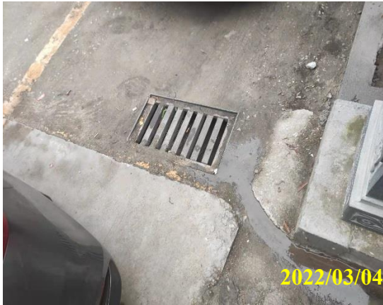
项目车间外雨水井盖
