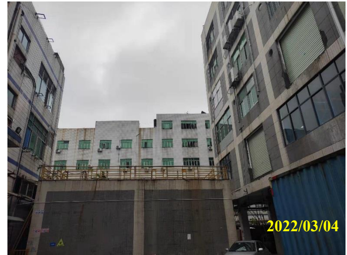
项目东面同栋厂房
