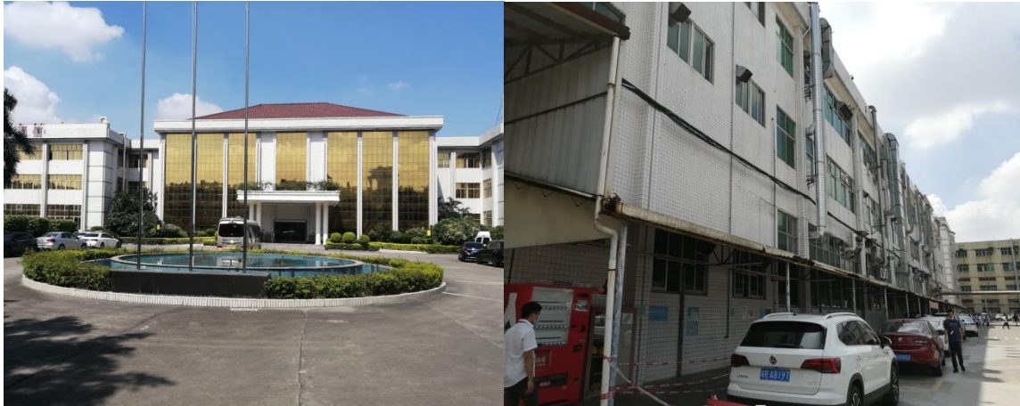
项目 A 栋厂房项目 B 栋厂房
